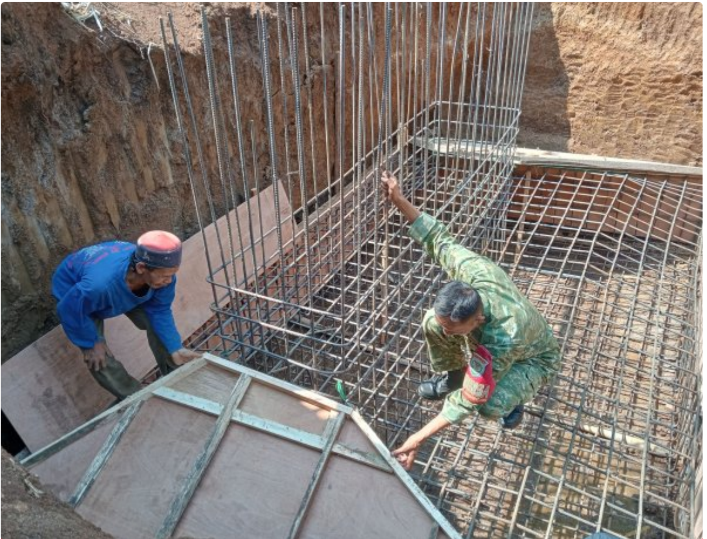
Pengecekan pemasangan bigisting
